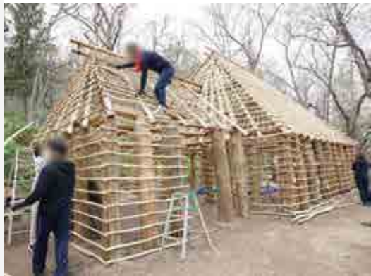
fig.01 建設中の外観
