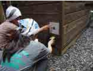
外壁の経年変化の調査状況
