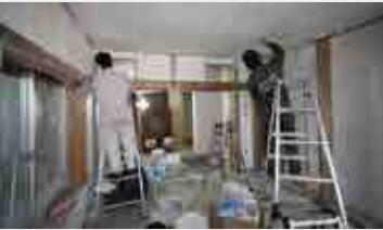
「佃島学校」のDIY作業。壁・天井の塗装塗りを行った。
