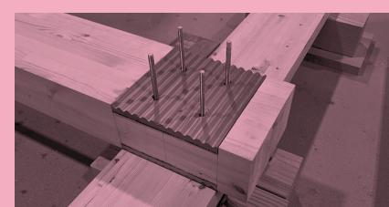
fig.03 圧縮木材で作成したパネルを組み合わせた木質ラーメン構造のための接合部
