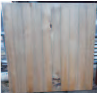
photo05 三ヶ月南面外観
