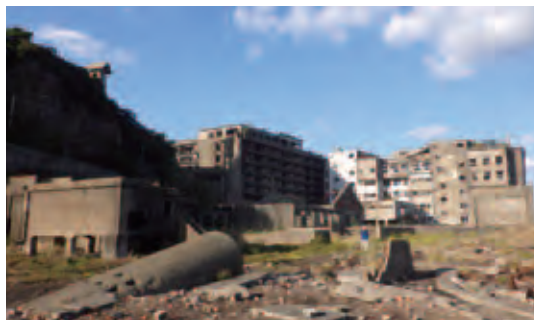
fig.01 上 | 歴史的建造物の補修では、外観の変化を極力低減させた補修方法が求められる。現地では、様々な補修を施した模擬試験体を設置して継続的に補修効果や外観変化を計測している fig.02 下・左 | 軍艦島に残存する建築物群では、徐々に、しかし確実に劣化が進行している。右側の70号棟は小中学校、中央の65号棟は島内最大の鉱員住宅、左の丘上に見える屋根は1号棟の端島神社(木造のように見えるがRC造)である fig.03 下・右 | 島内最古である1916年建設の30号棟。局部的な崩落が進行しており、倒壊が懸念される
