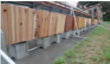
photo01 屋外暴露状況
