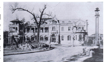
fig.2 北京大観より「日本公使館本館」
