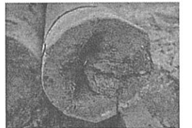
図 3 柱根の腐朽
