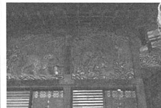
写真7 改修後拝殿正面
