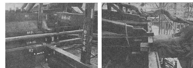
写真8 改修前出組（内側より）
