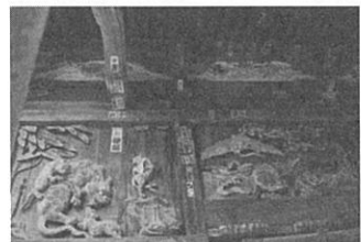
写真6 改修前拝殿正面
