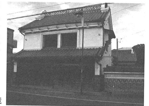
図6 長谷川家外観
