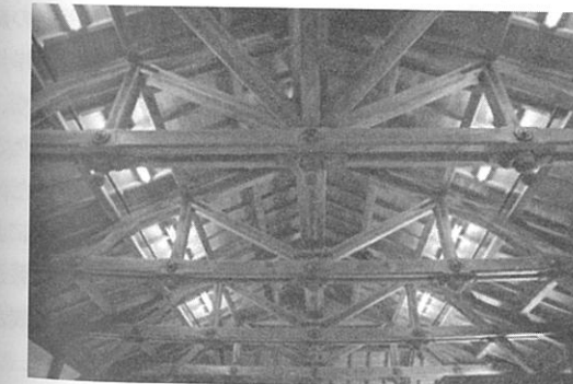
写真8 神宮農業館で写真7に該当する箇所
