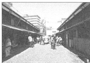
図1 旧川越織物市場現状外観 左：西棟 右：東棟
