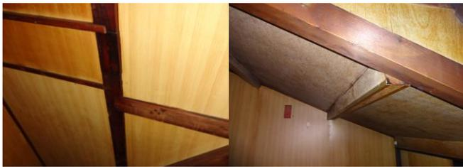
写真3 柱を切断・継ぎ足した跡
