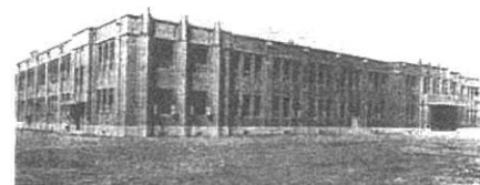
図 3 昭和 8 年建設の水産講習所本館
