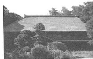
図 8 旧主屋外観写真
