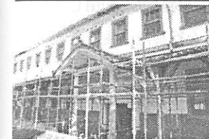
図 5. 白壁兵舎外観
