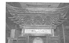
Photo.17 長運寺薬師堂厨子
