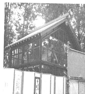
図3 工事中の旧本殿
