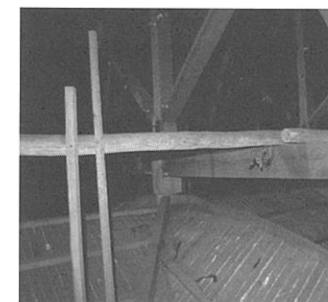
写真5 元町教会屋根裏
