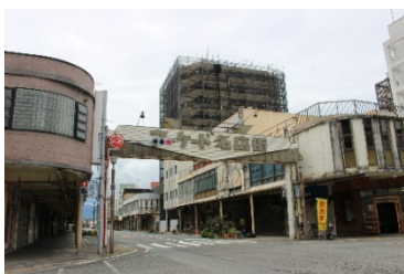
図1 沼津市本通防火建築帯(通称アーケード名店街)
