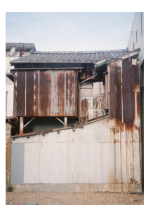
⑲錆びて赤みのあるトタンの外観
