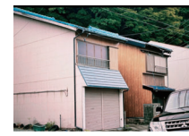
⑫建物に奥行きがある ⑬外壁にトタン ⑭一階に土間の高い空間
