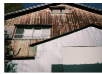
⑰隣接する建物が解体 →外壁の補修 →前の建物の跡が残る
