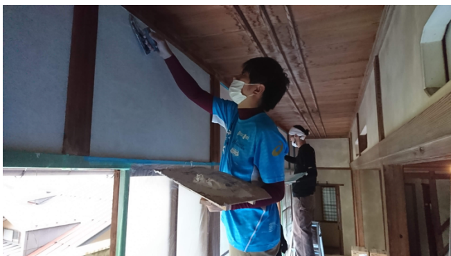
写真1 土壁に漆喰を塗る様子
