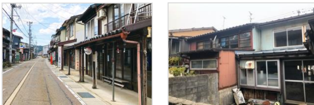
(右)写真3 通り沿いの雁木の様子 (写真：筆者)
