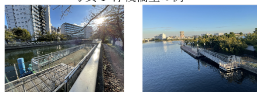
写真 1: 浮棧橋型の例
