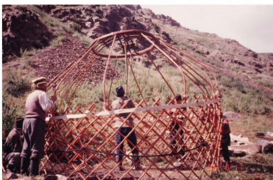
図 94 骨組みの組み立て 吉田世津子撮影 1996
