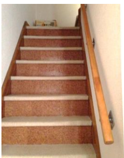
写真1 階段の滑り防止
