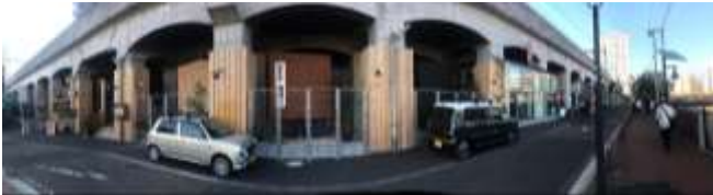
写真1 現在の高架下
